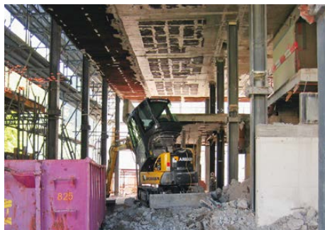
04 Rück- und Umbau des Zwischengesosses, das neu bis zu den peripheren, hier noch zweigeschossigen Fassadenpfeilern reichen soll, erforderten eine detaillierte Planung der Etappierung (Bild: Paul Lüchinger)
